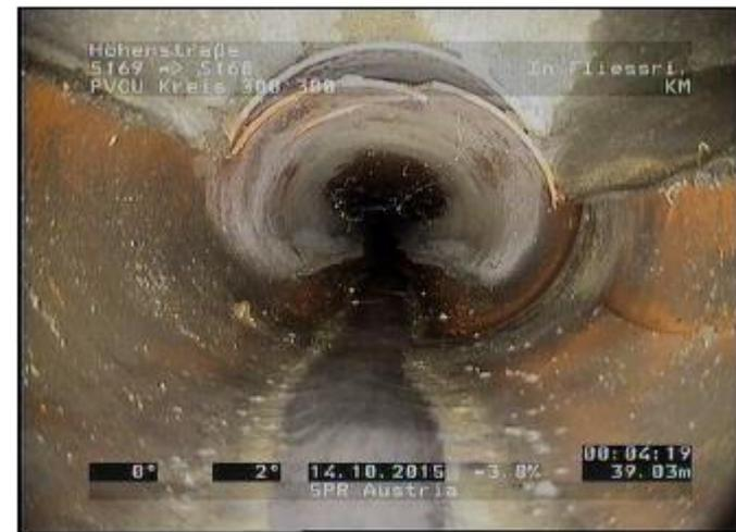
Abb./ Altrohrzustand PVCU DN 300
