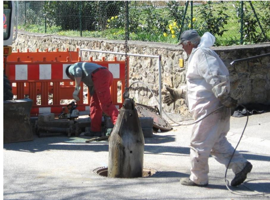
Abb./ Dynamische Berstmaschine erreicht den Zielschacht
