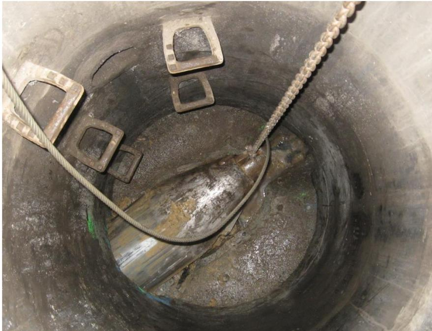
Abb./ Dynamische Berstmaschine wird aus dem Zielschacht geborgen
