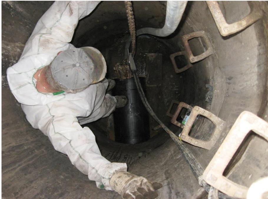
Abb./ Einzelrohreinbau mit hydraulischer Verspanneinheit
