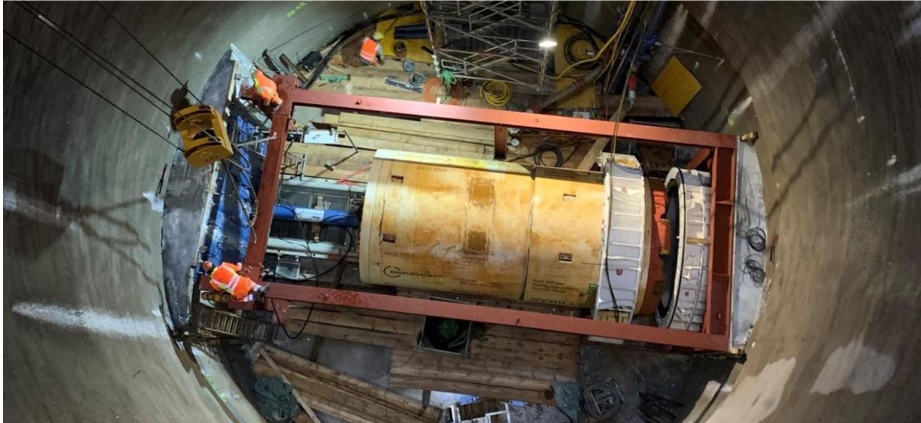
Einrichtung in der Startbaugrube
