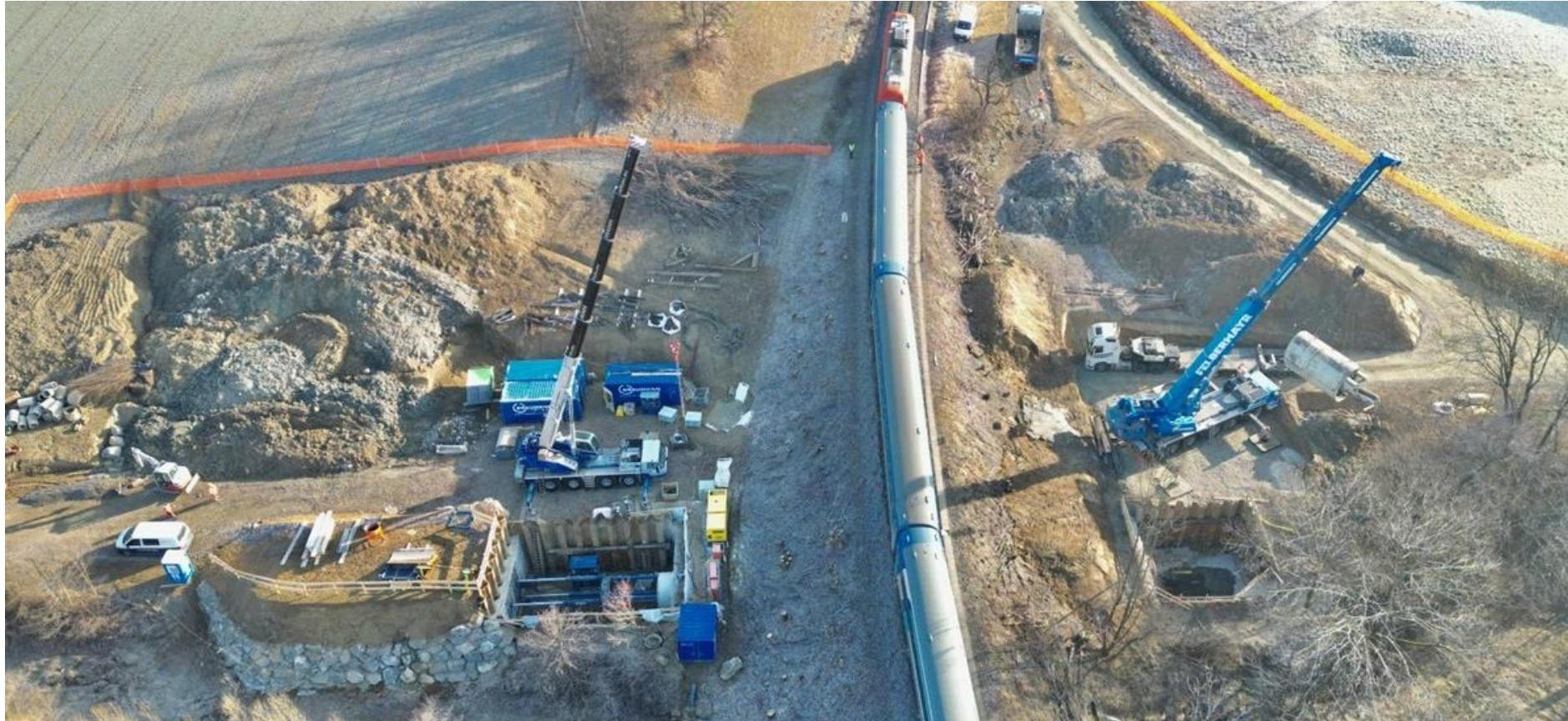
Gleichzeitiges Einheben der Vortriebsrohre während der Bergung der Vortriebsmaschine
