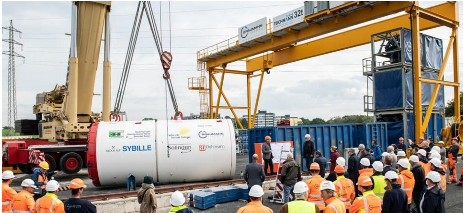
Baustelleneinrichtung während der Maschinentaufe
