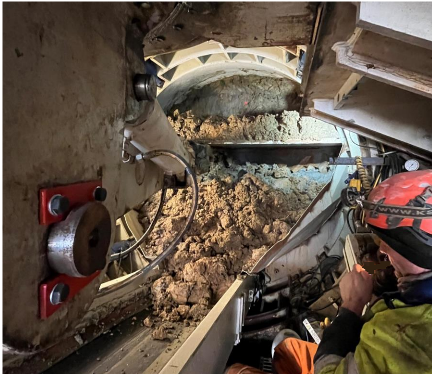
Abbauvorgang an der Ortsbrust
