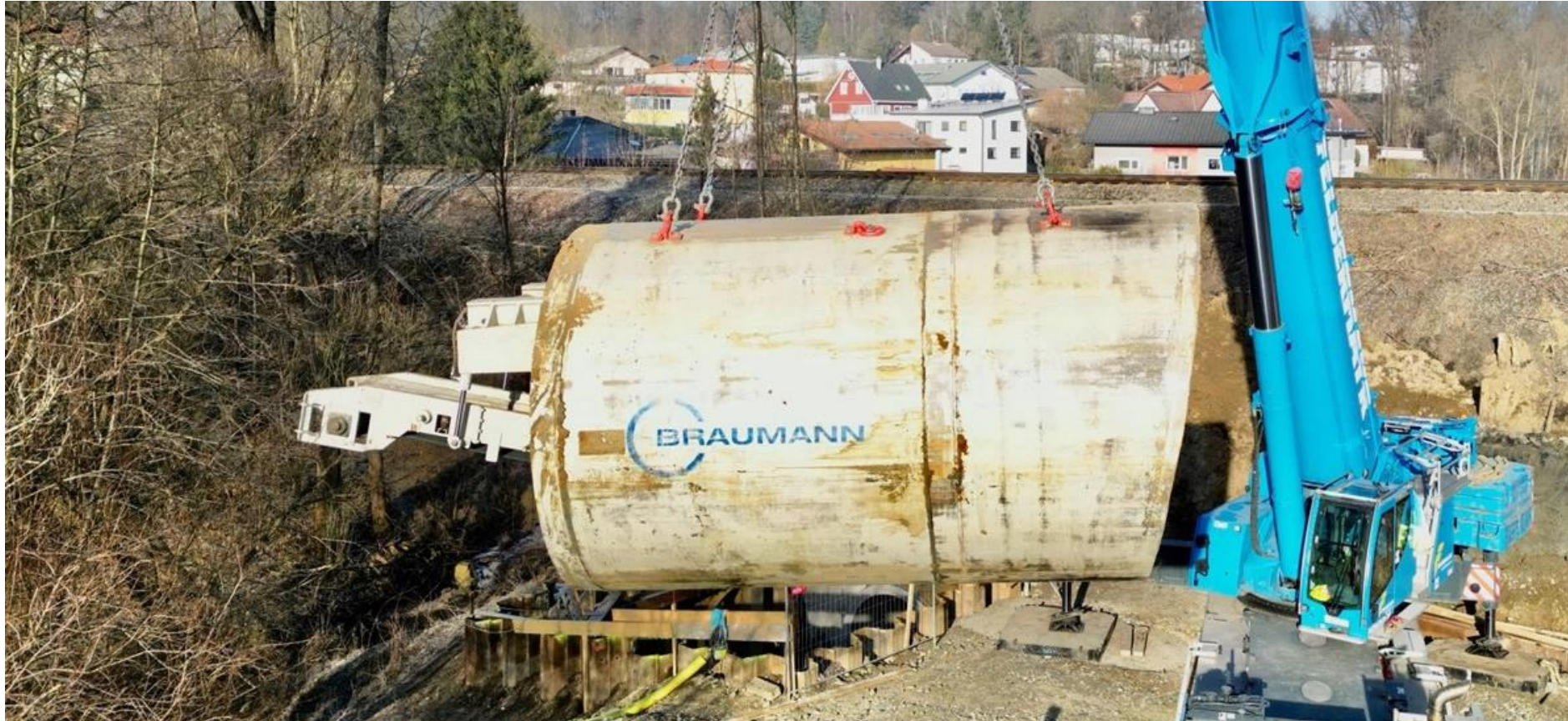
Bergung der Vortriebsmaschine im Zielschacht
