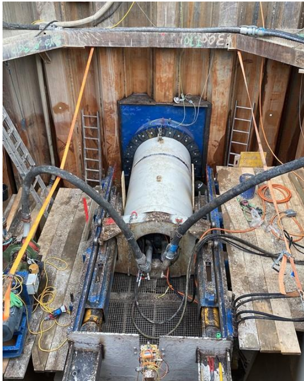
Presseinrichtung in der Doppelstartgrube
