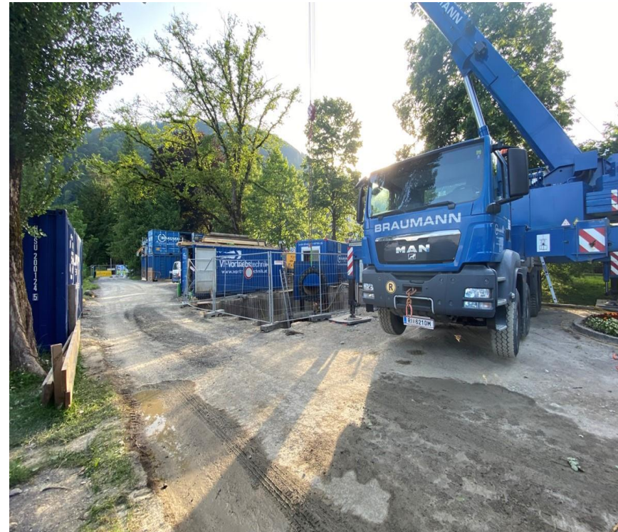
Baustelleneinrichtung ober Tage
