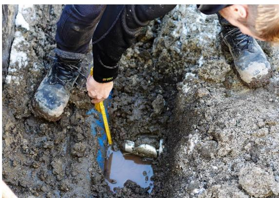
Bild 4: Bohrkopf (freigelegt nach Ankunft an Hauptleitung)
