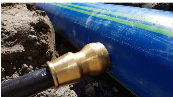
Bild 2: Spezialfitting zur Anbindung an Hauptleitung
