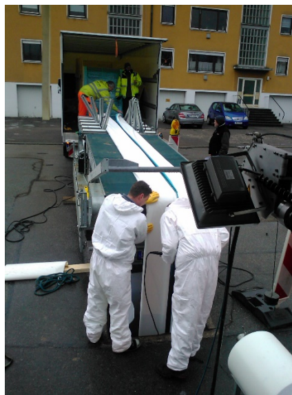
Bild 12: Einzug des glasfaserverstärkten Liners DN 800
