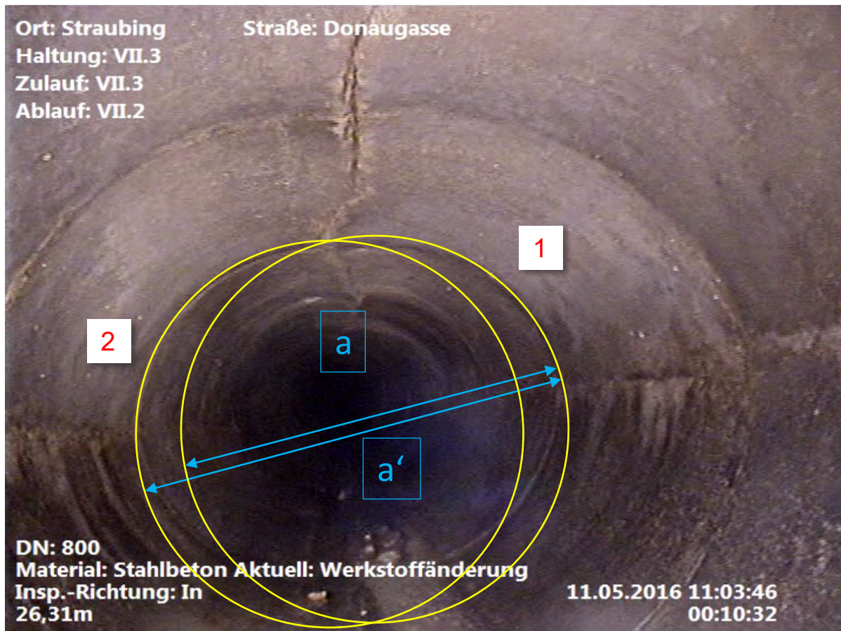
Bild 8: Ermittlung der Gelenkringvorverformung nach Methode B
