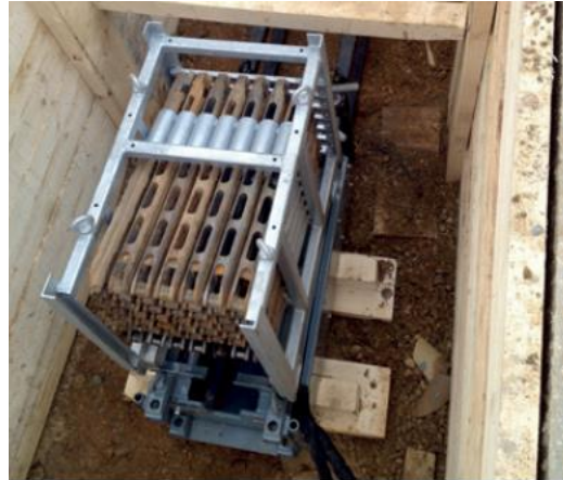
Maschinengrube: ca. 5m lang, 2m breit und 2,5m tief Hydraulisches Bohrgestänge
