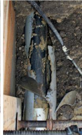
Berstkopf (li.): vor dem Eindringen in das Altrohr Sprengung (re.): Berstkopf weitet das alte Rohr auf
