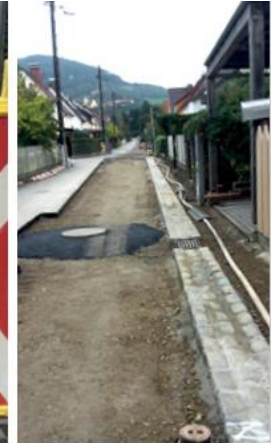
Offene Bauweise (re.): ganzer Straßenzug wurde aufgedigelt – Befahren der Straße und Zufahren zu den Häusern nur zu bestimmten Zeiten möglich
