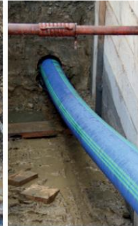
Mantelschutzrohr: wird mit Berstkopf in die bestehende Leitung eingezogen
