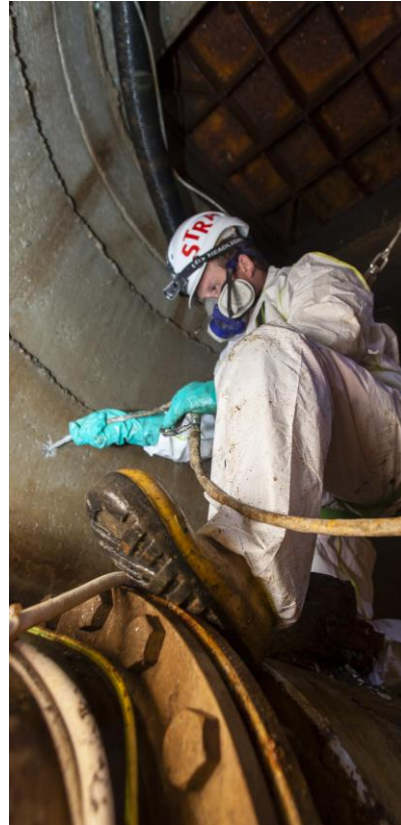
Händische Sanierung 5 kva
