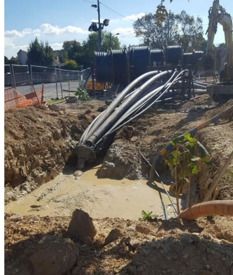
Zugkopf und Kabel / Kabelschutzrohre
