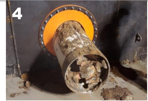
4 Durchbruch der AVNS im Zielschacht
