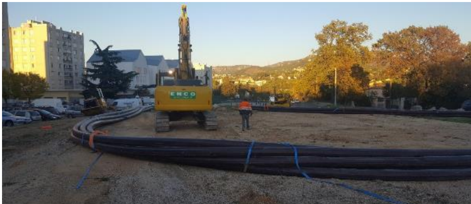
Vorbereitung des Kabelbündels auf der Pipeside
