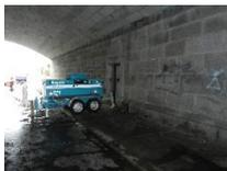
Für das Einziehen des Windenseiles wurden in der Kammer des Linzer Donaufufers entsprechende Umlenkrollen angebracht und die Winde vor der Eingangstüre positioniert.
