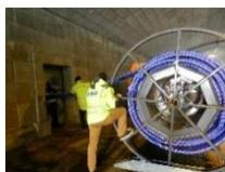
Auf der Urfahrner Seite wurde die Rolle mit dem Primusline® in Stellung gebracht. Für beide Maßnahmen war lediglich das Absperrn von einer Fahrspur und einem Parkstreifen in den Unterführungen nötig, weitere Einschränkungen für den Straßenverkehr gab es nicht.
