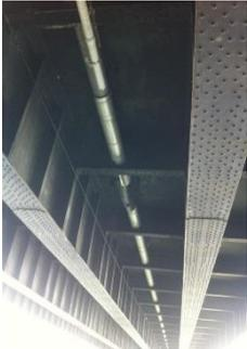
Die Edelstahlleitung war auf einer Länge von 260 m unter der Brücke abgehängt und nur durch die Brückenfundamente zugänglich.
