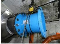
Am 2. Tag wurde der 2. Übergangsverbinder montiert und die Sanierung somit seitens der QUABUS GmbH abgeschlossen.
