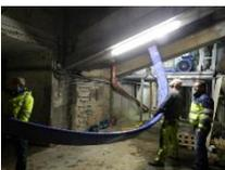
Nach dem Einziehen des Windenseiles wurde der Primusline® montiert und über die ganze Länge in die Leitung eingezogen. Der Zeitaufwand für das Einziehen betrug nur ca. 2 Stunden.
