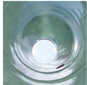
Abbildung 1 Blick aus dem sanierten Schacht.
