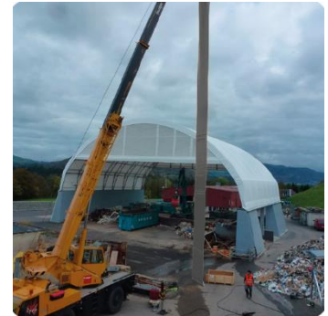
Abbildung 3 Einbau Sonderlänge mit ca. 25m.
