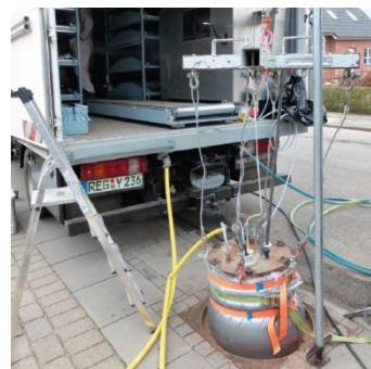
Abbildung 4 Installation und Aushärtevorrichtung
