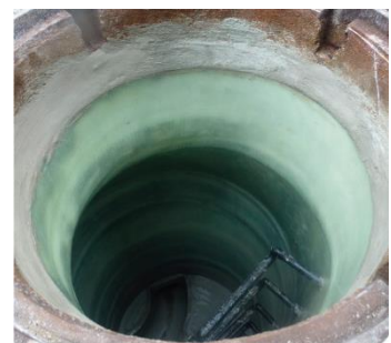
Abbildung 2 Blick in den sanierten Schacht
