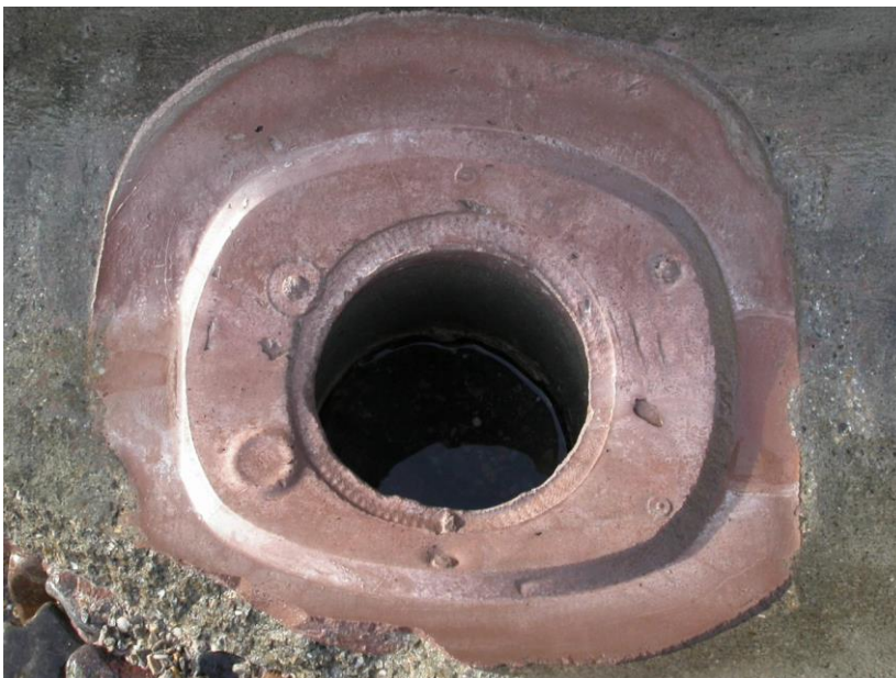
Bild 2 getesteter Stutzen mit ERGELIT-Kanaltec CF
