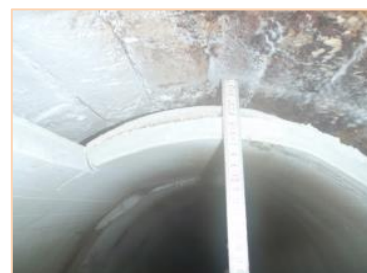
Die verdeckte Falte führte zu einem Ringspalt.
