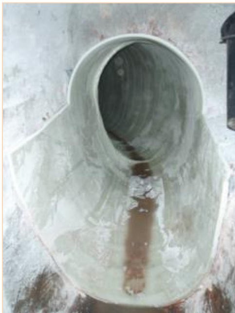
Bild links: Durch enge Rohrführung bedingte Faltenbildung im inneren Kurvenbereich.
