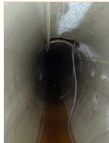
Bild links: Durch enge Rohrführung bedingte Faltenbildung im inneren Kurvenbereich.
