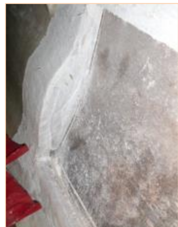
Verdeckte Falte in einem Synthesefaser-Laminat: Von innen zeigt sich einen scheinbar harmloser Buckel – am Altrohr staut sich hingegen das Laminat.
